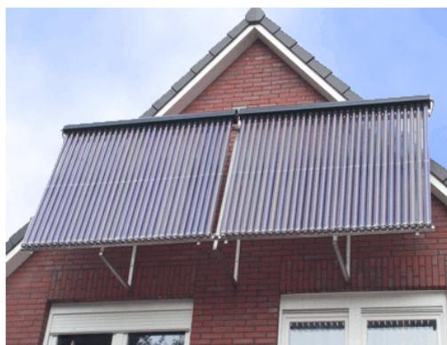
4.2 Solaranlagen an Balkonen oder Terrassenbrüstungen im Sockelgeschoss haben die gleiche Orientierung aufzuweisen wie die wesentlichen fassadengestaltenden Elemente, wobei der körperhaften Einbindung sowie einer materialmäßigen und farblichen Abstimmung besondere Bedeutung zukommt.
