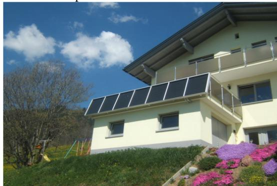
Anlagen, die im Bereich des Sockelgeschosses von Gebäuden angebracht werden sollen, können auch eine andere Neigung als die der Gebäudefassaden aufweisen, sofern eine gestalterische Integration auf andere Weise, z.B. durch entsprechende Randelemente, Verblechungen oder Holzverschalungen erreicht werden kann.
