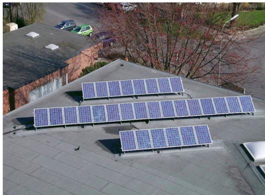
3.2 Der Dachüberstand der Kollektoren darf maximal 1,0 m betragen. Der Dachüberstand wird im Bereich der Solaranlage von der Dachfläche bzw. von der Oberkante der Attika zum höchsten Punkt der Anlage gemessen.
