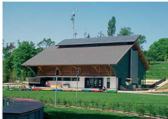
In Abb. 15 sind die Dachkanten nicht unterbrochen und als durchgehende Linien wahrnehmbar. Die Solaranlage tritt als integrierter Bestandteil des Gebäudes in Erscheinung.
