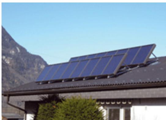
Photovoltaikanlagen werden aus Gründen der Hinterlüftung oft nicht als „Indach-Anlage“ ausgeführt und Röhrenkollektoren müssen aufgrund ihrer Bauweise in einem gewissen Abstand zur Dacheindeckung montiert werden.
